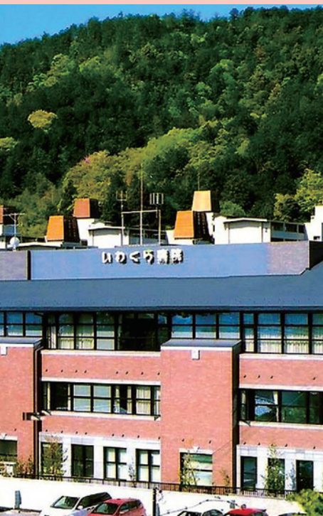
現在のいわくら病院本館（2005年 改築年当時）
